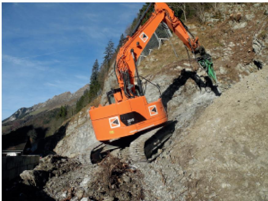
**Beim Wegweiser** hat der Bagger schon einige Kubikmeter Fels abgetragen. Jetzt braucht es dann gleich eine Spezialmaschine, um die Erde abzutragen. 22 Meter in der Höhe gilt es zu entfernen. Auf der Strasse wird eine ca. 8m hohe Schutzwand erstellt. Der gleiche Bagger ist dieser Tage unter der Brücke bei Kapellboden im Einsatz. Dort entfernt er das Fundament welches für den Baukran erstellt werden musste. Und das waren schlussendlich nicht weniger als 70 m<sup>3</sup> Beton!
