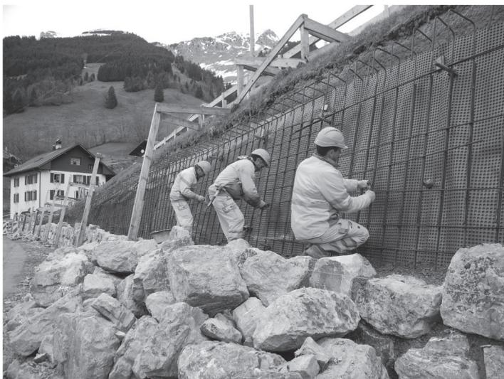
Die Natursteinmauer am Hohlenweg mit einer Länge von etwa 100 m und einer Höhe von durchschnittlich 3.50m wird noch einige Arbeitsstunden abverlangen.
