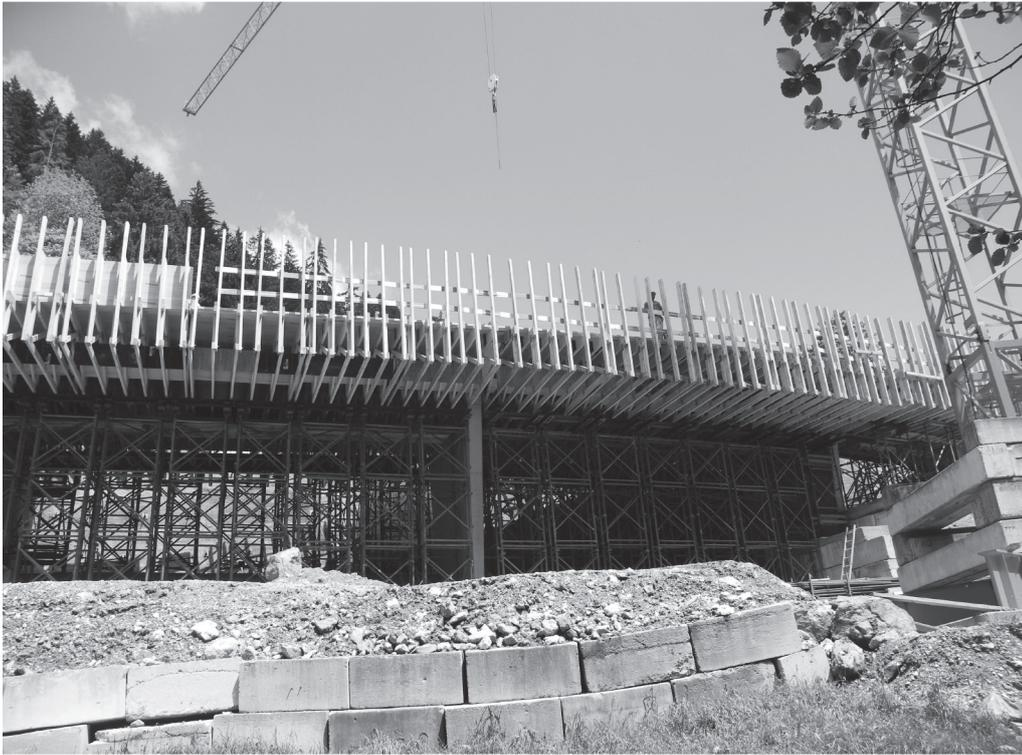
*Eindrücklich das Bild mit dem „Innenleben“ der Brücke bei Kap-pelboden. Weil von den Hängen und sonst überall Wasser fließt, wird das kanalisiert und wo heute noch tiefe Löcher und Gräben sind, wird selbstverständlich später aufgefüllt.*
